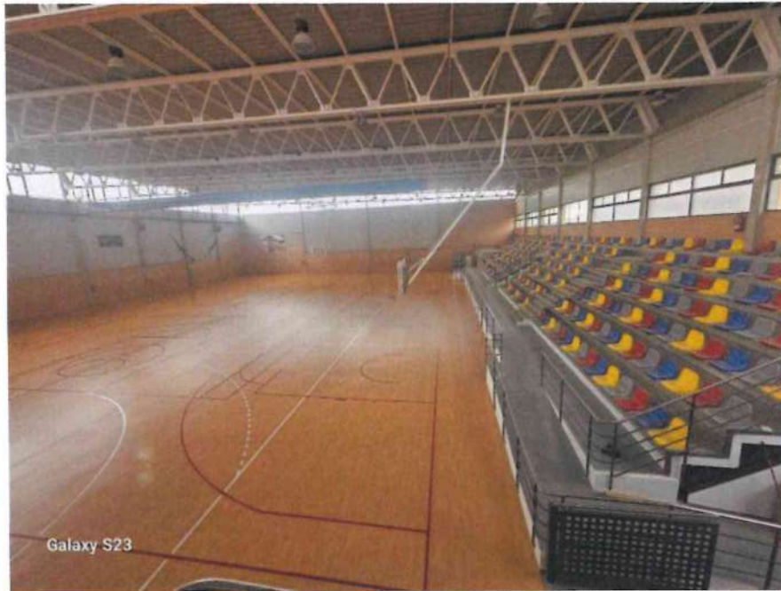
Imagen 11 - Pabellón deportivo tras la reconstrucción de pista y gradas.
