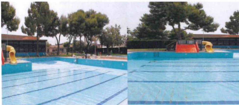
Imagen 8 - Piscinas y depuradoras rehabilitadas
