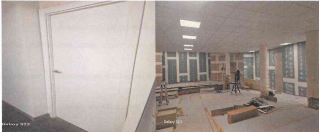
Imagen 9 - Nuevas carpinterías y acabados interiores.
