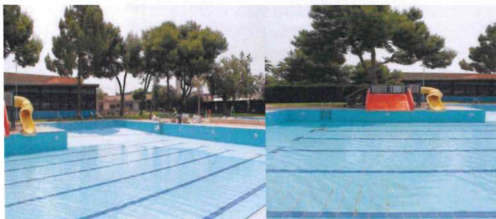
Imagen 8 - Piscinas y depuradoras rehabilitadas
