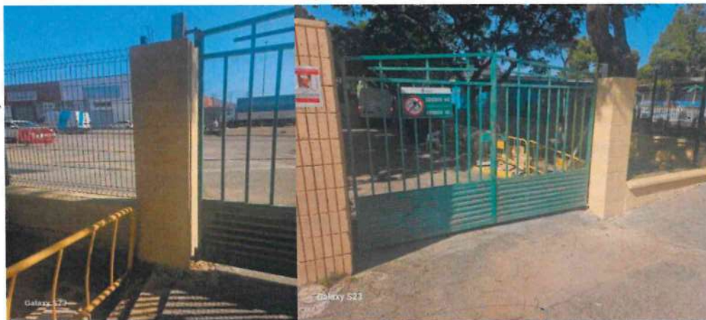
Imagen 12 - Cierre perimetral reforzado y pintado.
