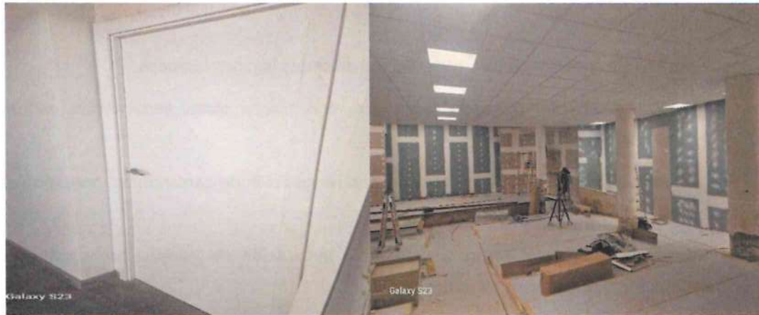
Imagen 9 - Nuevas carpinterías y acabados interiores.
