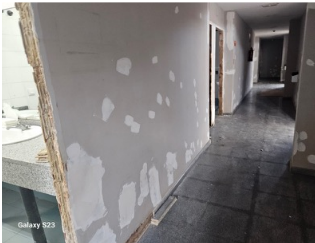
CUADROS ELÉCTRICOS, CARPINTERÍA Y REMARCOS AFECTADOS POR EL AGUA (2,5 M DE ALTURA).
