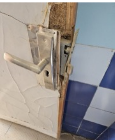
CUADROS ELÉCTRICOS, CARPINTERÍA Y REMARCOS AFECTADOS POR EL AGUA (2,5 M DE ALTURA).
