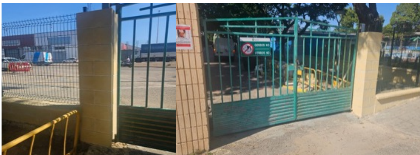
CIERRE PERIMETRAL REFORZADO Y PINTADO.
