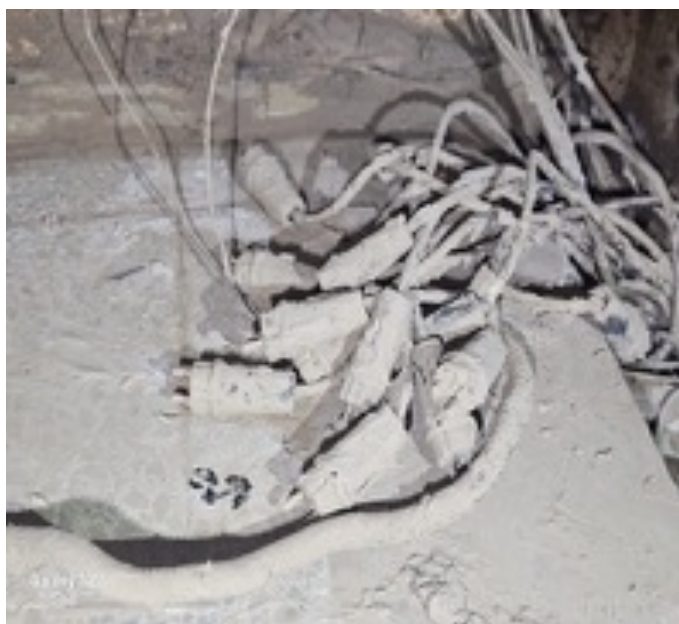
INSTALACIONES ELÉCTRICAS Y MUROS GRAVEMENTE DAÑADOS POR LA DANA
