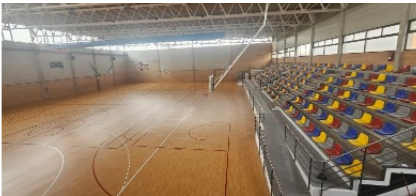
PABELLÓN DEPORTIVO TRAS LA RECONSTRUCCIÓN DE PISTA Y GRADAS.
