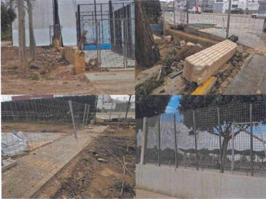
Imagen 7 - Instalaciones eléctricas y muros dañados por la DANA
